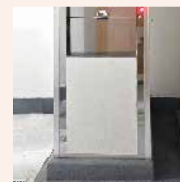
アイニチダムウェーター設置後
